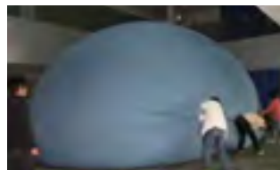
プラネタリウムの設置作業
